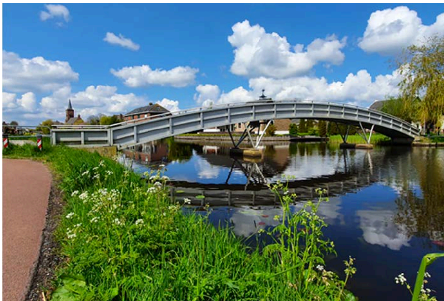
De aluminium brug in Bleskensgraaf.
